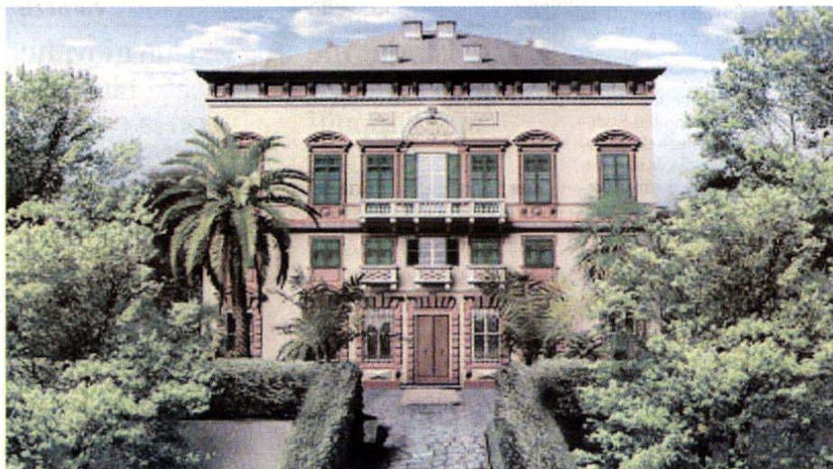
Una veduta complessiva dell'ex Hotel Astoria di Albissola una volta concluso il restauro
